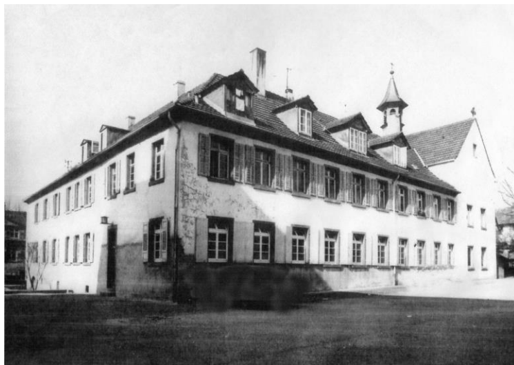
Abb. 4 Das Großherzogliche Gymnasium im alten Kapuzinerkloster
